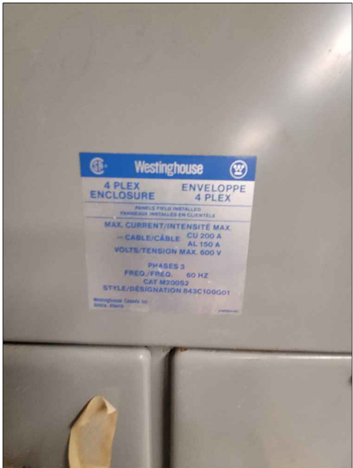
(2) 600V MCC DETAILS SCALE: NONE
