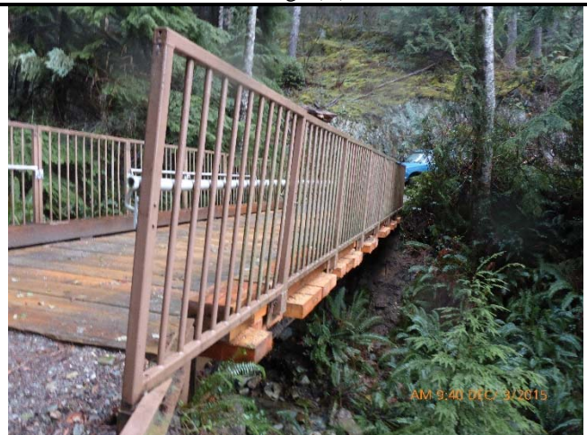
006 – View of South side of Bridge (D)
