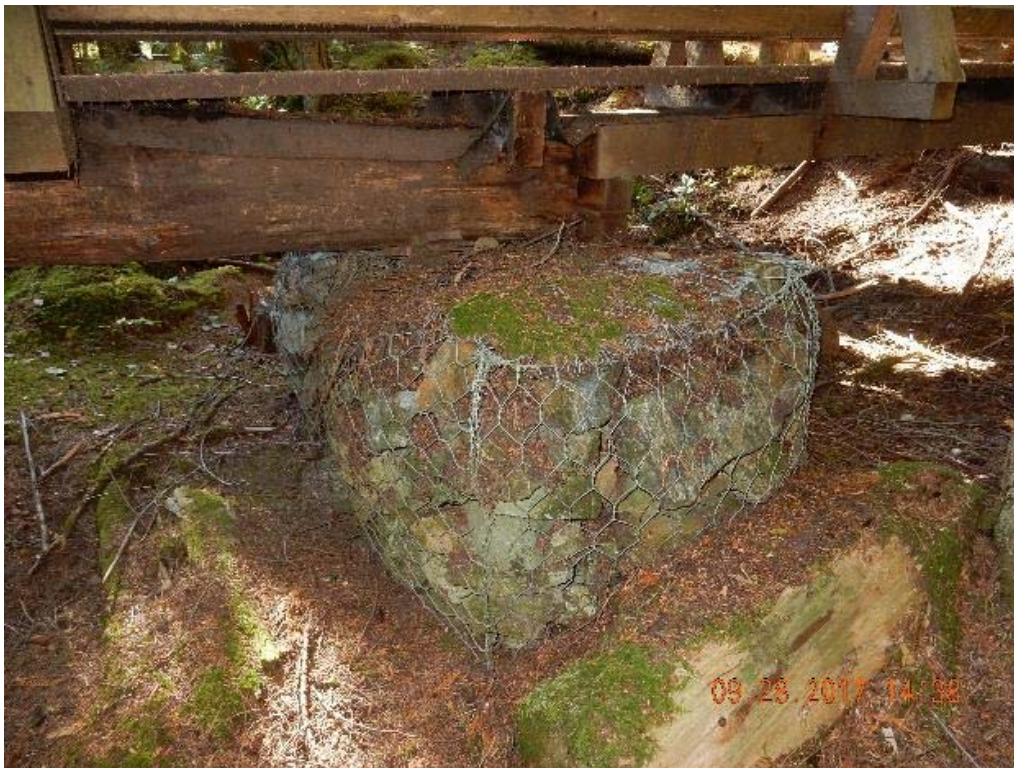
P08 – Pier (DSCN9613.jpg)
